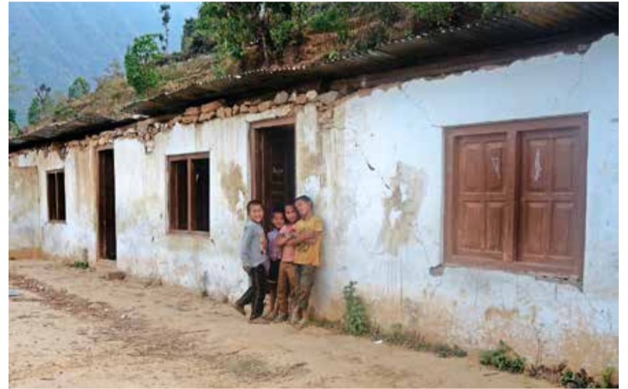
Wiederaufbau der durch das Erdbeben von April/Mai 2015 zerstörten Schule in Kaule, Nepal.
